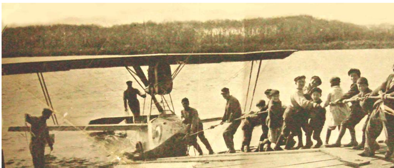
Recuperación del Nieuport M-7 N/S 20784 por parte del personal de la Misión Militar Italiana en San Fernando. Archivo Dirección de Estudios Históricos de la Fuerza Aérea. Colección Biedma
