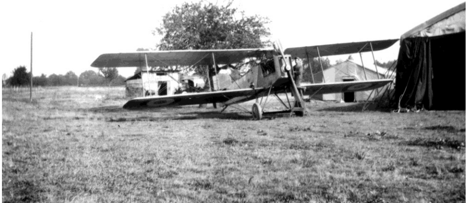
Foto de un Breguet XIV en mantenimiento muy probablemente tomada en 1921 frente al hangar Bessoneau de la Compañía Franco Argentina de Transportes Aéreos de San Isidro
