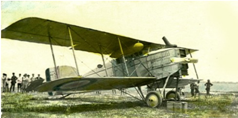
Breguet XIV Limousine equipado con tanques de combustibles subalares en el plano superior para vuelos de largo alcance
