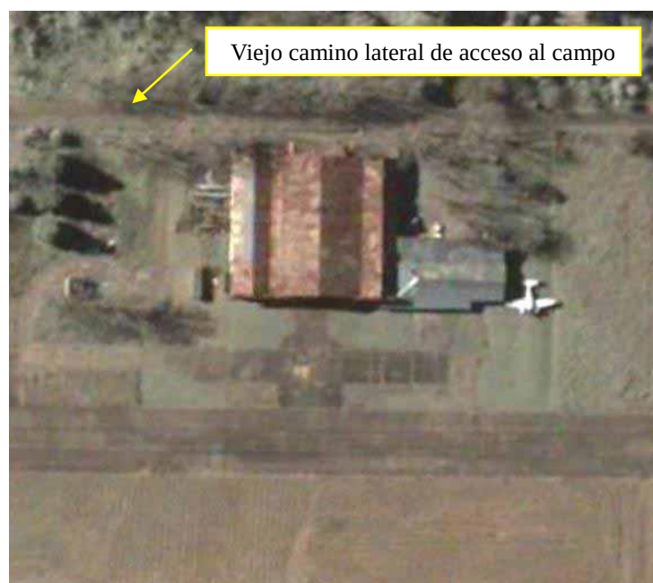
Hangar de Pan American (2007)
