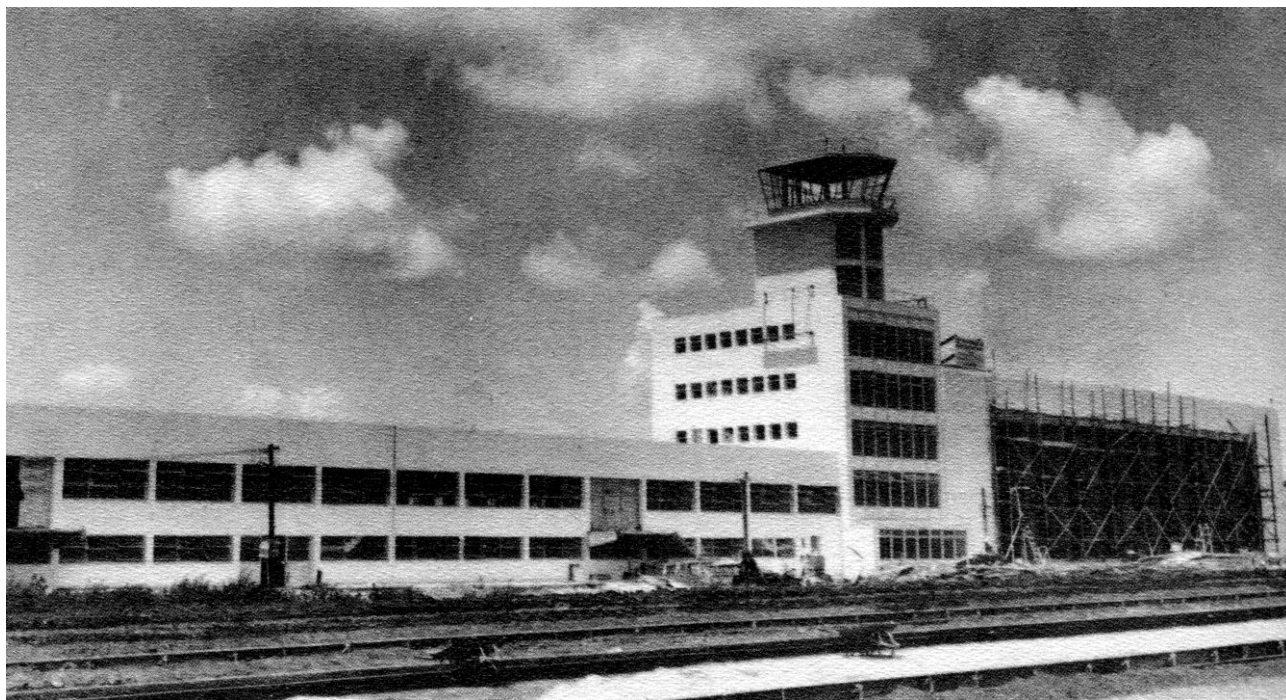
Construcción de instalaciones en el aeropuerto Morón. 1946 125
