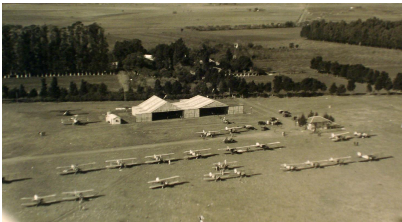
Vista aérea de las instalaciones. 22 de junio de 1935, al lado de la casilla izquierda se puede apreciar el Loening C-2C Air Yacht 81
