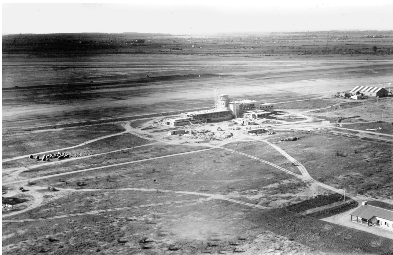
Construcción de instalaciones en el aeropuerto Morón. 1946 124
