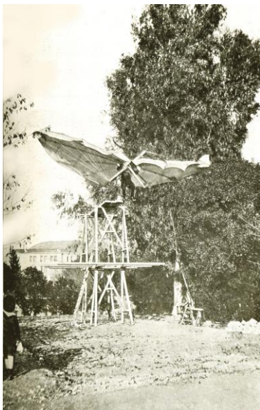
Izquierda: Sistema construido por el Capitán Ferber para ensayar en Niza su prototipo N.º 4 el 7 de diciembre de 1901 2 . Derecha: simulador empleado por Louis Bleriot
