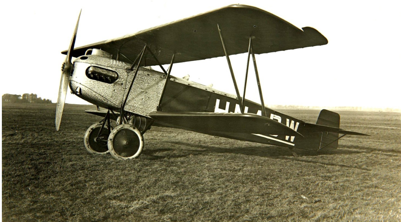
Fokker C.IV H-NABW (N/C 4118) importado a la Argentina. En la parte inferior detrás del tren principal se aprecia el radiador circular Lamblin
