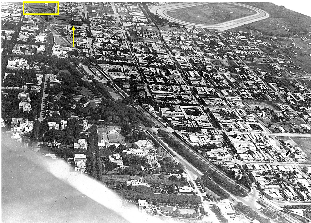
Foto aérea realizada a comienzos de la década del '20 donde se aprecia el hipódromo Nacional y en el recuadro amarillo el edificio principal del Parque Aerostático, la flecha indica las instalaciones de la usina de Gas (Colección Borra)
