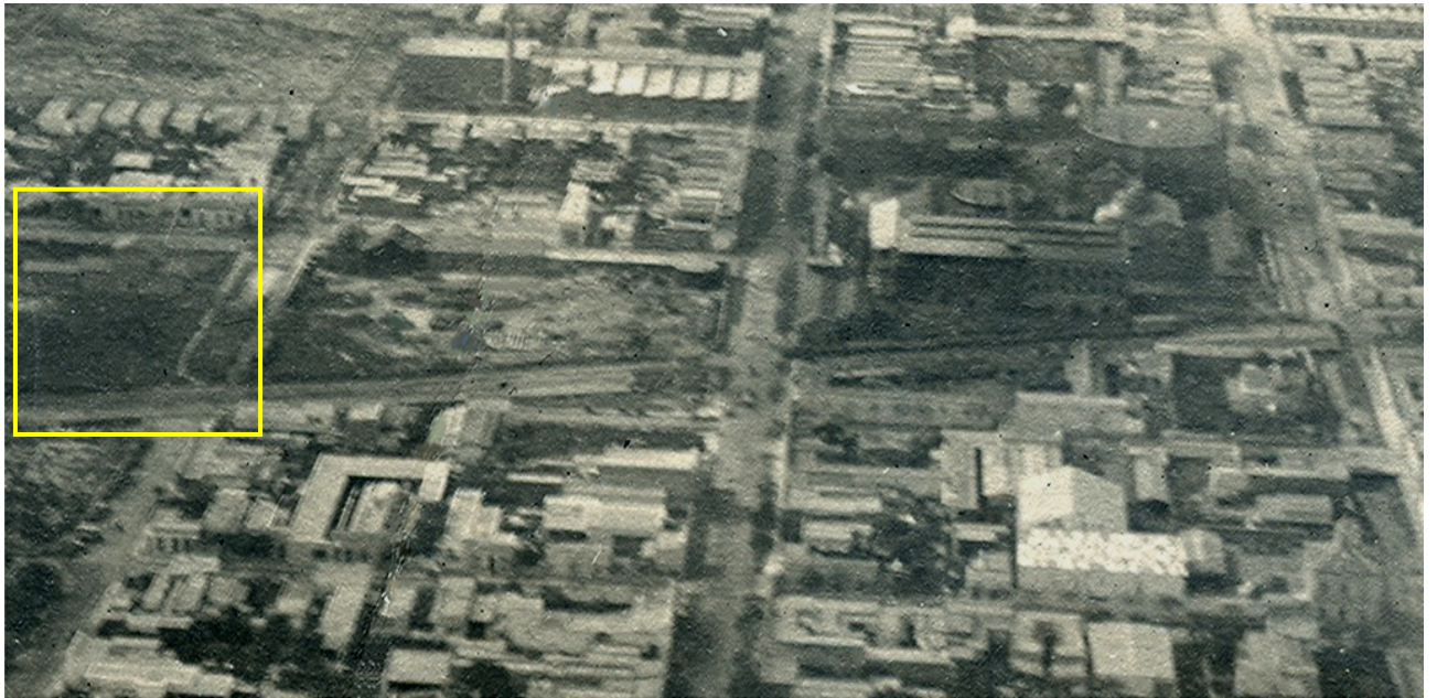
Vista aérea del edificio del Parque Aerostático
