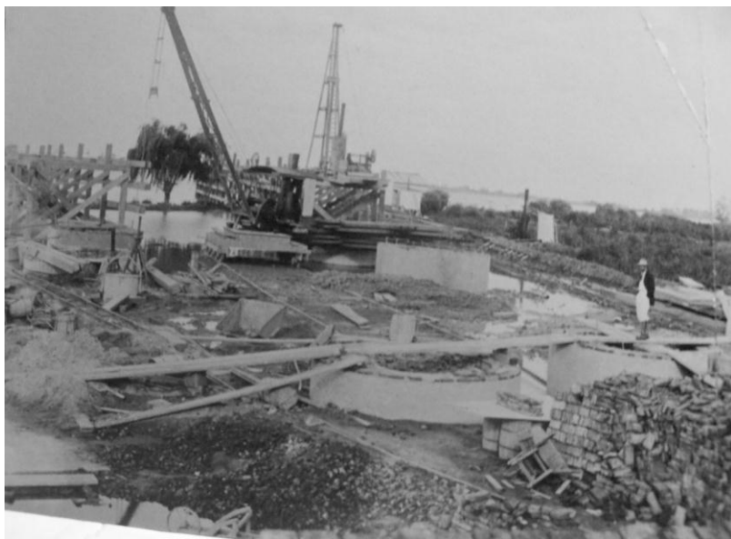
Vista de las obras del puente de transferencia en 1907 (Gentileza Gabino Pérez)
