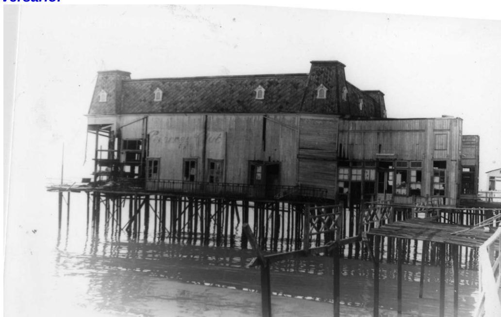
FOTOGRAFIA QUE DEMUESTRA LO DETERIORADAS QUE ESTABAN LAS INSTALACIONES AL SER DEVUELTAS
