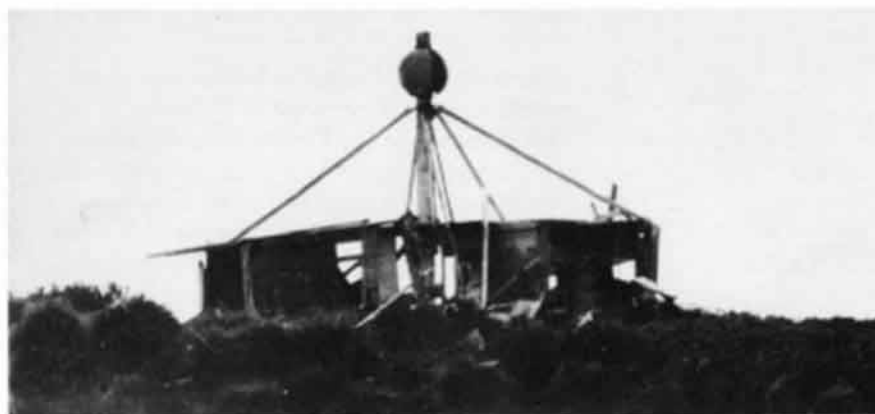
La bocha de zinc es una señal diurna. No emite luz. Su forma es para que se destaque del fondo.
