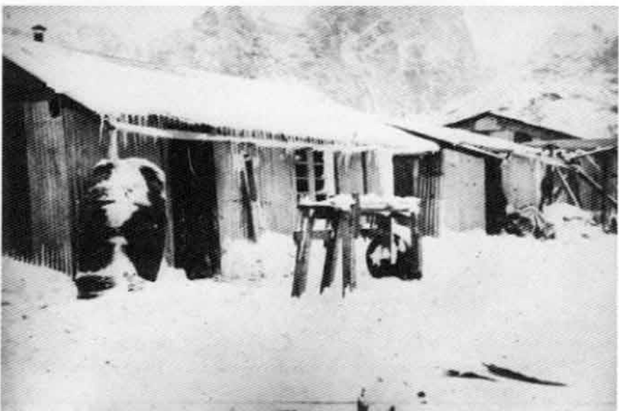
Galpones para talleres en Puerto Cook.
