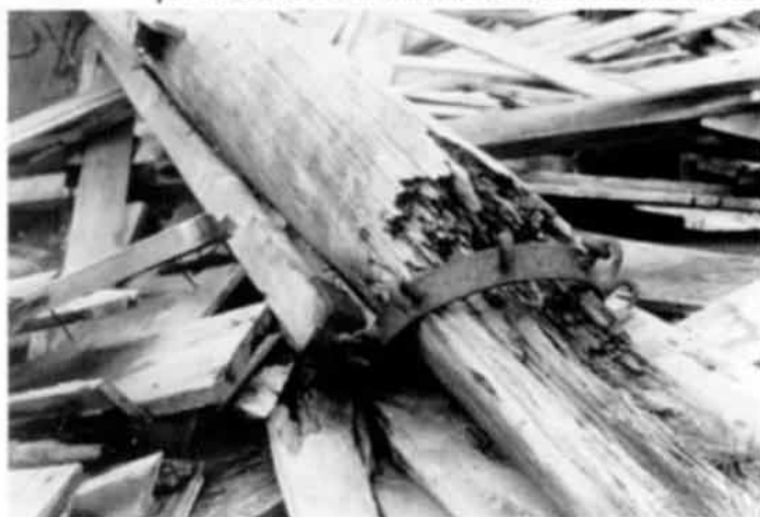
El palo central de 6.50 m de altura. Nótese el herraje para sostener los dieciseis tirantes del sobretecho.
