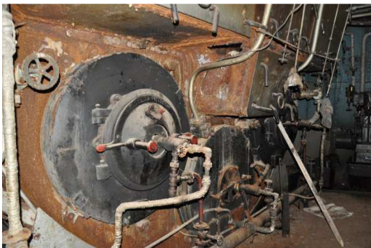
TRIUNFADOR quemadores de caldera y máquina a vapor de triple expansión
